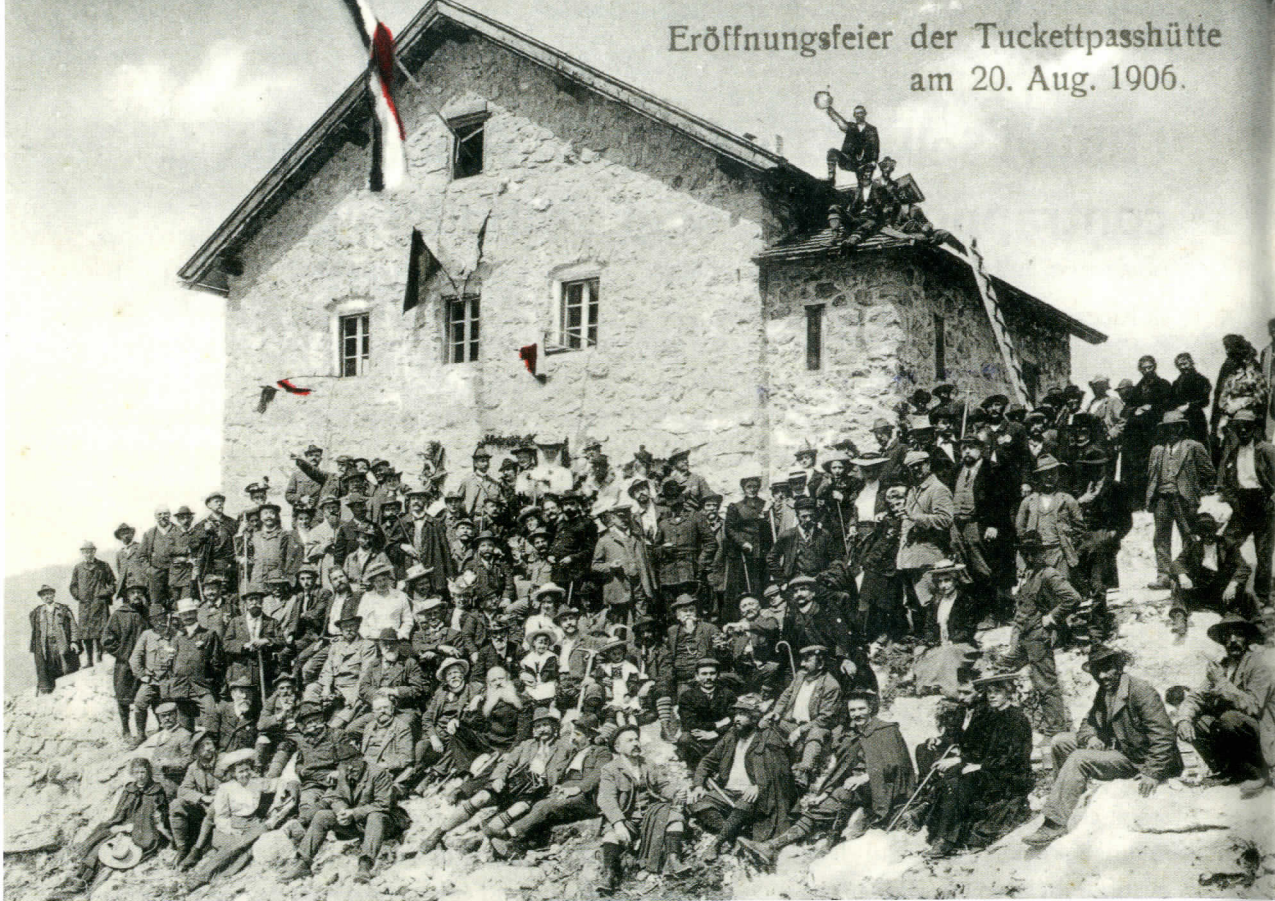
Inaugurazione Rifugio Tuckett, 20 agosto 1906 (Biblioteca della montagna-Archivio storico SAT, Trento)
